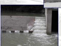
Dettaglio della scala rimonta pesci. È' formata da 7 "aradini" ed evita che lo sbarramento diventi un ostacolo insuperabile per la rimonta dei pesci
