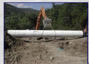
Fasi della posa della condotta interrata. Le condotte in acciaio hanno un diametro di 120cm e sono interrate alla profondità di 1m.
